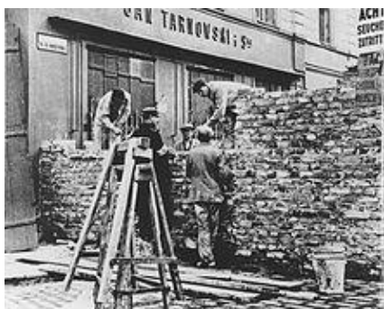
Budowa murów getta na ulicy Świętokrzyskiej
