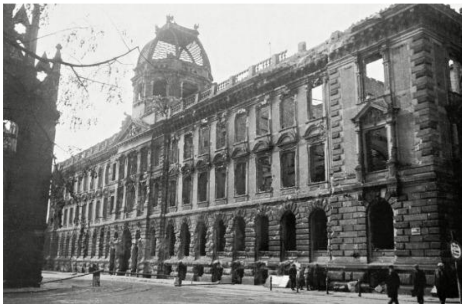
Zniszczony budynek Poczty Głównej
