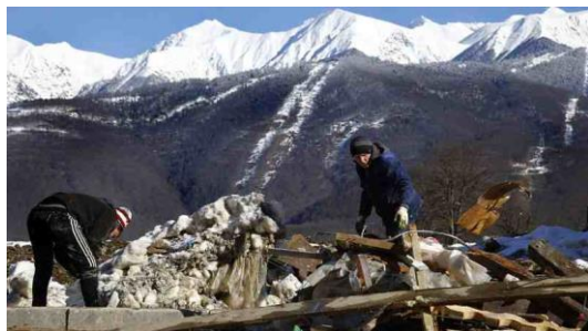
W Soczi nadal trwają prace
