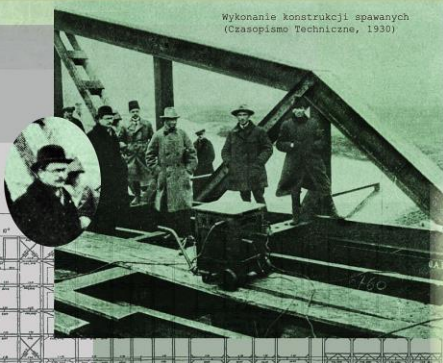
Wykonanie konstrukcji spawanych (Czasopismo Techniczne, 1930)
