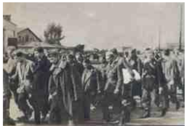
W drodze do obozu przejściowego
