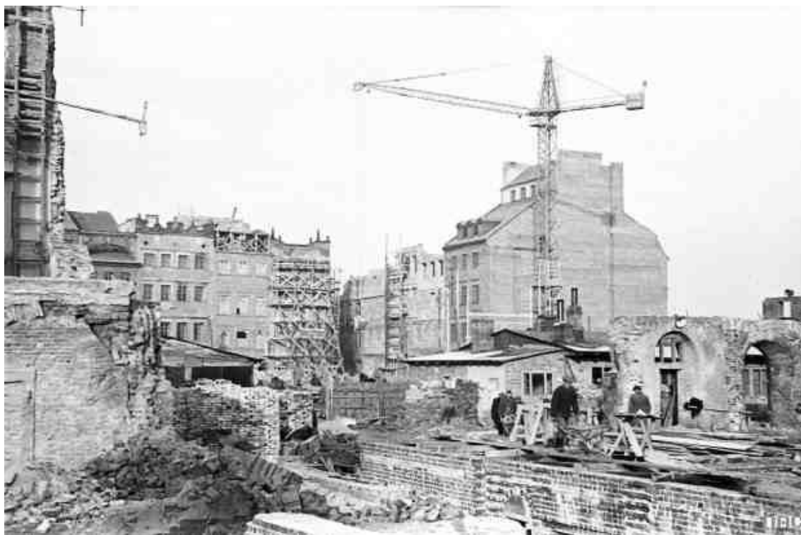
Odbudowywane kamienice i robotnicy budowlani. Widok z lat 1952-53 w kierunku strony Dekerta na Rynku Starego Miasta
