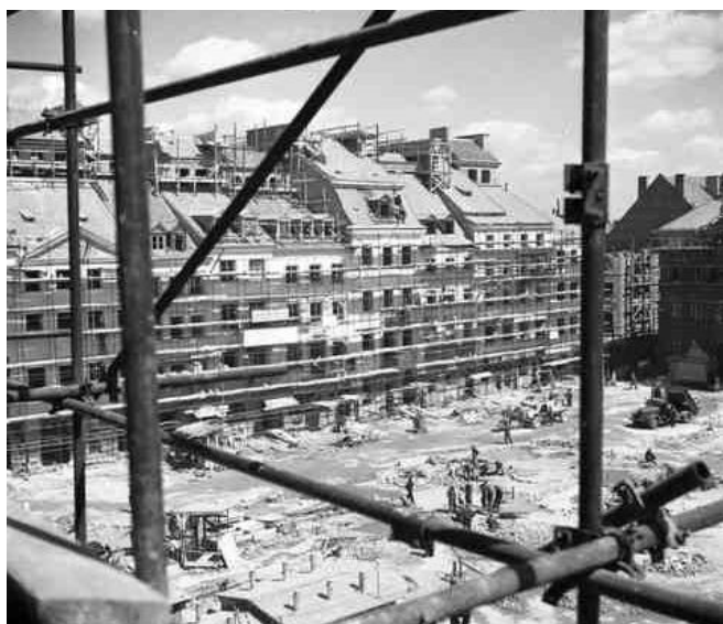
Kamienice z rusztowaniami po stronie Barssa.
