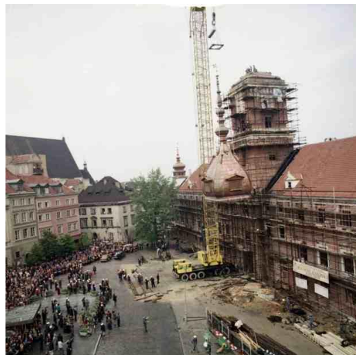
Montaż hełmu na wieży zegarowej – czerwiec 1974 r.
