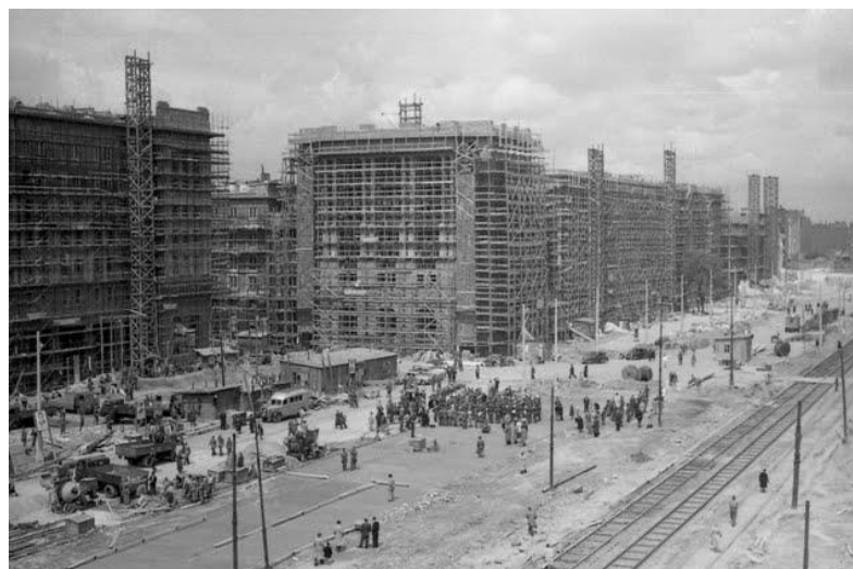
MDM w budowie
