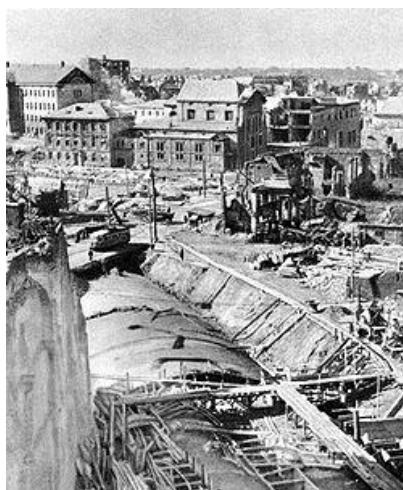
Budowa tunelu trasy W-Z
