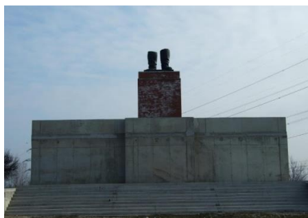
„ Buty ” – rekonstrukcja pozostałości po pomniku „ Wodza ”.
