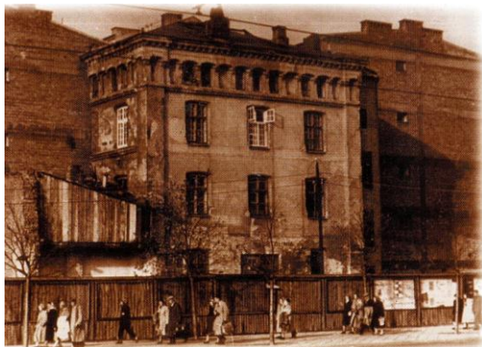
Budynek po fabryce tytoniu – „Union”
