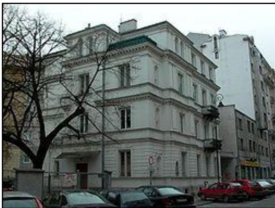
Kamienica pod nr 19
