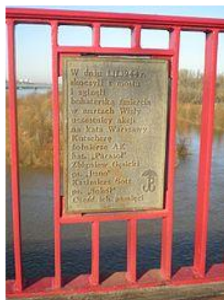
Tablica na balustradzie mostu Śląsko-Dąbrowskiego
